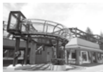
「新トラ舎」空中回廊（全景）▶P.53
