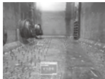
あと施工せん断補強鉄筋完了 （底版・側壁）▶P.55
